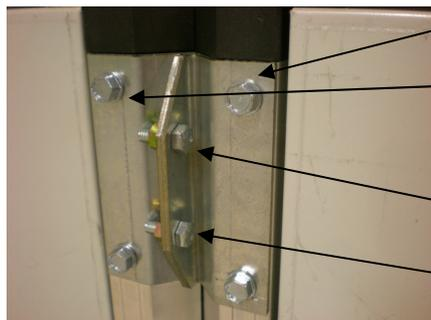
B / Fixer ensuite chaque patte d'assemblage sur les profils de chaque module à l'aide des vis 6.3x22 TH autoforeuses
